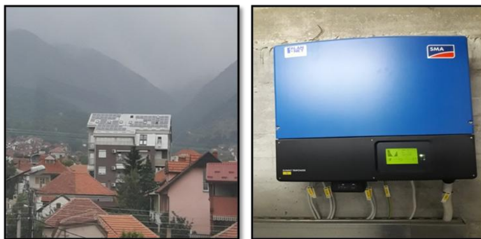
Slika 2.1. Zgrada na kojoj su instalirani PV paneli (a) i invertor montiran u garaži objekta (b)
